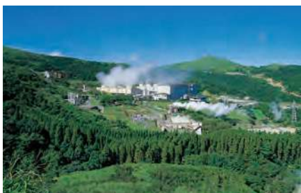
九州電力(株)八丁原発電所
