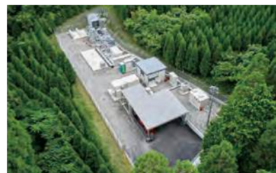
(株)大林組 グリーン水素製造実証プラント
