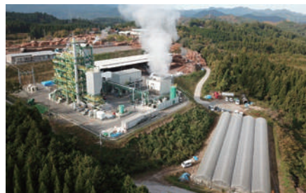
日本フォレスト(株) 天瀬発電所
